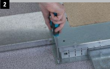
2 Вставить кабель-каналы и привинтить к полу
