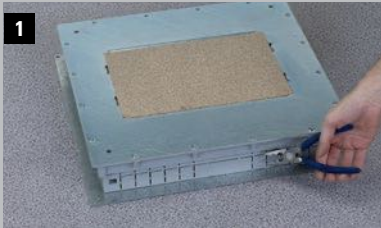
Прорезать входы для кабель-канала
