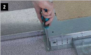
Вставить кабель-каналы и привинтить к полу
