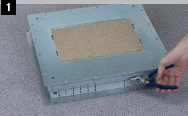
1 Прорезать входы для кабель-канала
